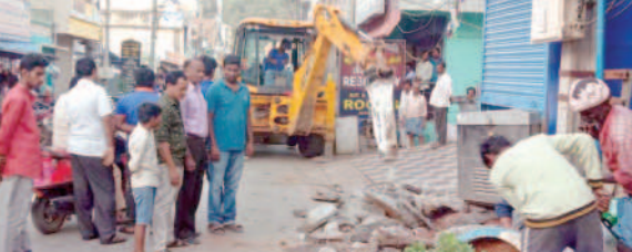
అండర్ గ్రౌండ్ కేబుల్ ఏర్పాటుకు చేపట్టిన పనులు
